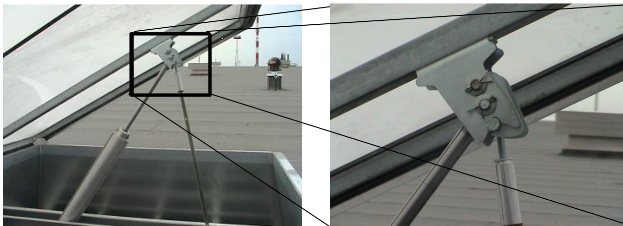
Rys. 28. Połączenie siłowników z konsolą hakową.
