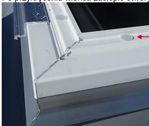
Rys. 12. Montaż zaślepek w wieńcu PVC.
