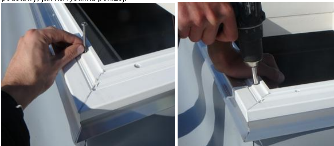
Rys. 11. Przymocowanie wieńca PVC do podstawy metalowej.
