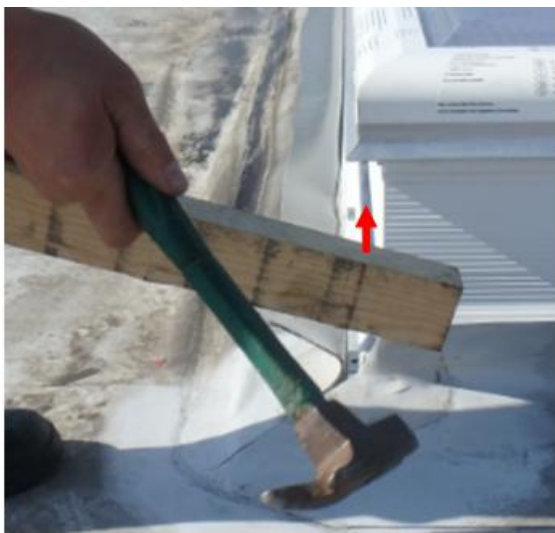
Rys. 20. Nabijanie łącznika.
