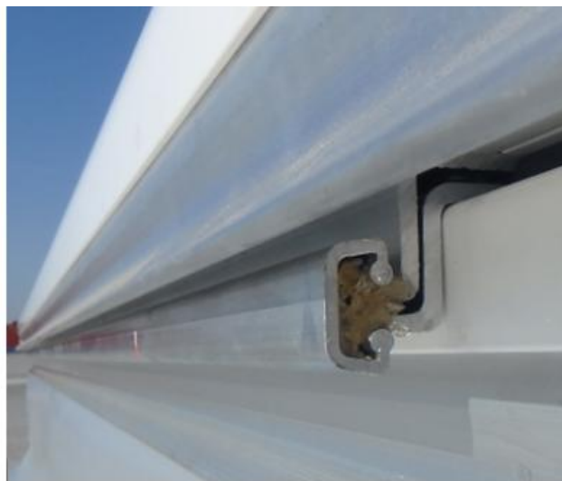
Rys. 21. Zawias z zamontowanym łącznikiem.
