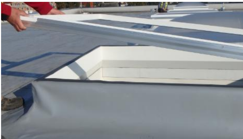
Rys. 10. Układanie wieńca PVC na uszczelce PES.
