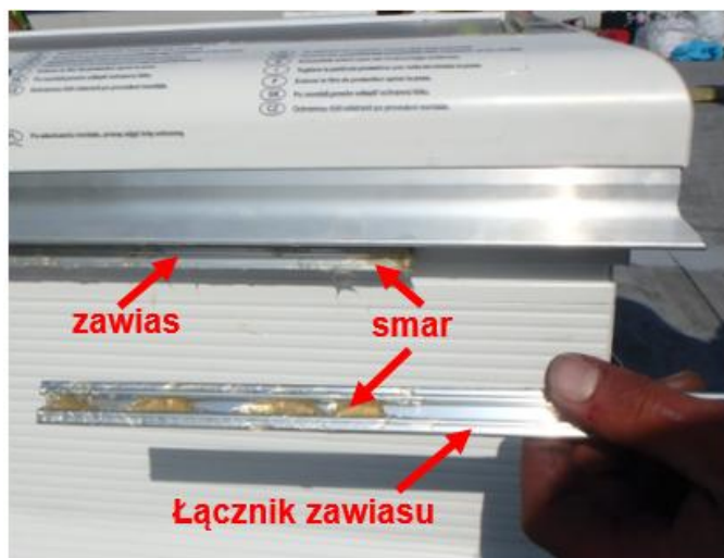
Rys. 18. Smarowanie zawiasu.
