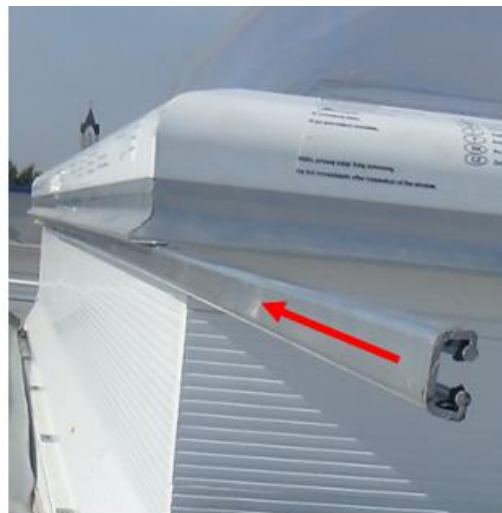
Rys. 19. Nasuwanie łącznika.
